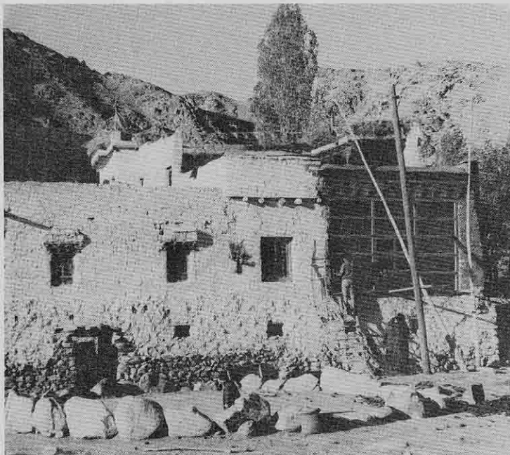
Trombe-vägg under uppförande
